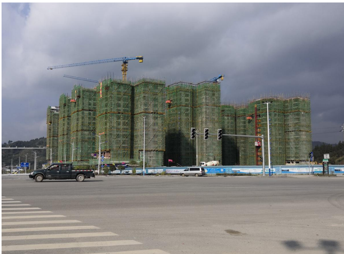
三江县浔江半岛上的祥云广场在建工程
